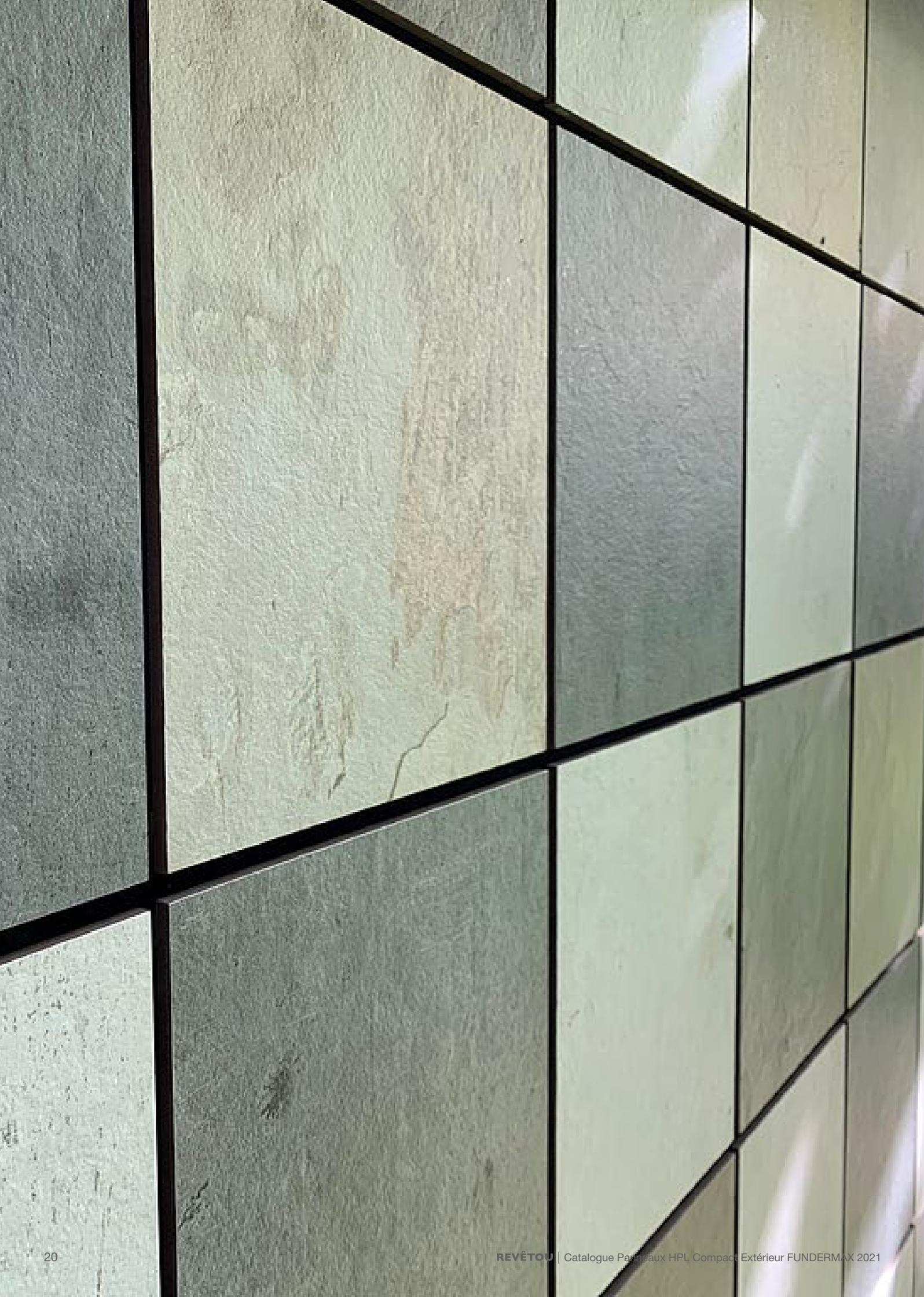
D'une manière générale on privilégiera des panneaux Max Exterior, Max Interior épaisseurs 8, 10 ou 12 mm. Les dispositions de perforations des panneaux Max Exterior et Max Interior dépendent des dispositions d'entraxes de fixations et
